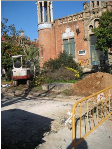
Vista del Pavelló de Sant Salvador abans d'iniciar els rebaixos de la R400 al tram 1
