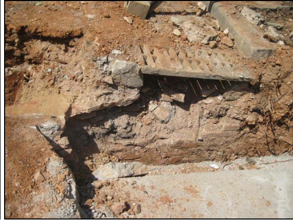
Imatge de la claveguera UE 623 recolzant-se a un embornal.
