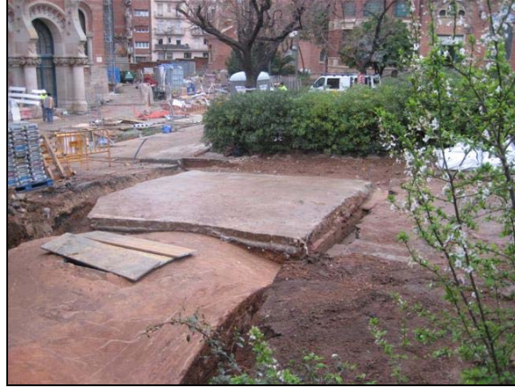
Vista de la planxa de formigó que reforça la volta de la galeria original al tram 2
