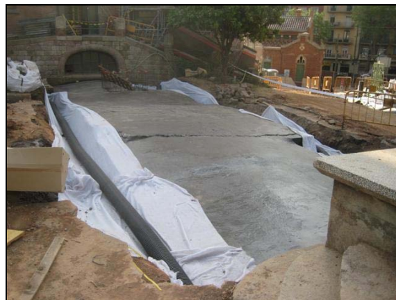
Vista de la rasa 400 un cop formigonada
