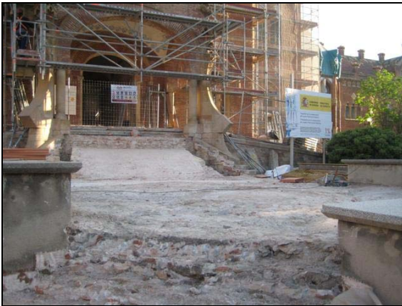
Imatge de l'entrada del Pavelló central i aquesta primera zona sobreelevada un cop picat el paviment
