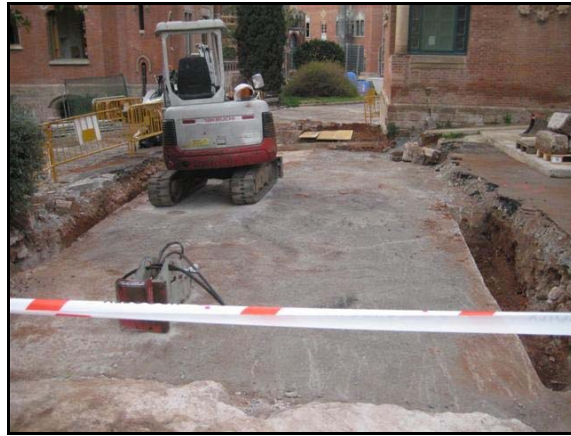
Vista SE del Tram 1 de la Rasa100
