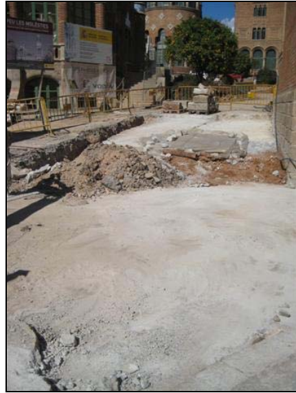
Vista NE de R200 tram 1 on s'observa també el reforç de formigó
