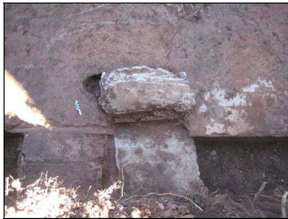
Detall del contrafort original, el primer començant per l'esquerra de la imatge i el contrafort de formigó amb el pegat.
