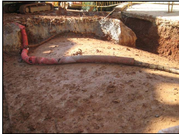
Volta del túnel original a continuació de la claraboia.
