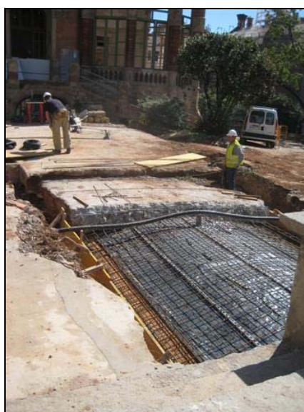
Preparació per abocar formigó al tram 3 de R300
