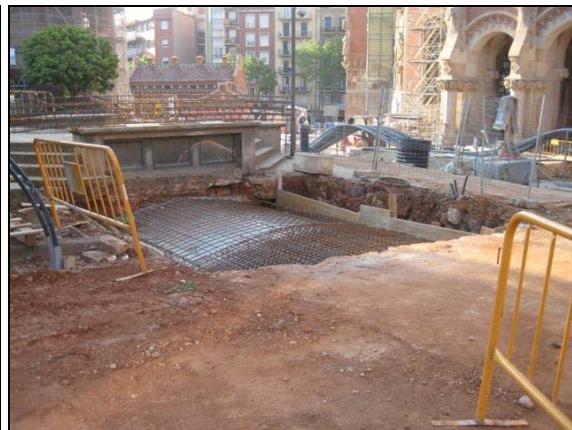
Tram 3 de R600 abans de formigonar
