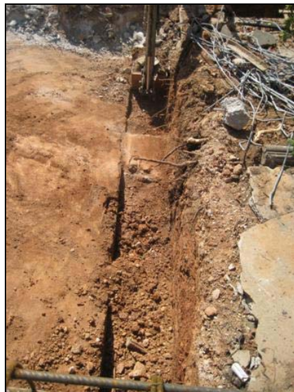
Imatge NW de la Rasa 600a del tram 3 on s'observa el contrafort UE 624
