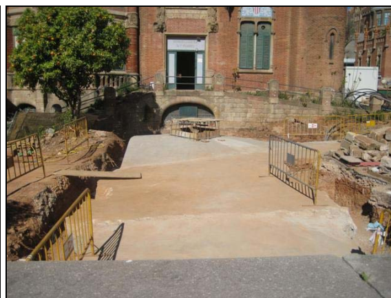
Un cop abocat el formigó al tram 1
