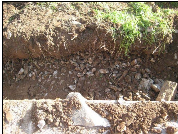
Nivell de graves de R100a al tram 1
