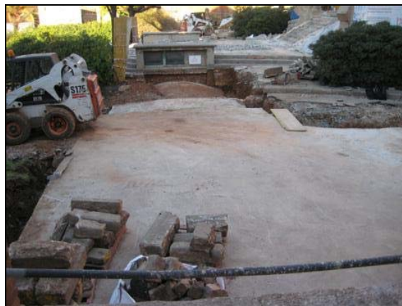
Vista NW de la R300 un cop finalitzada i on s'observa també la unió amb R100
