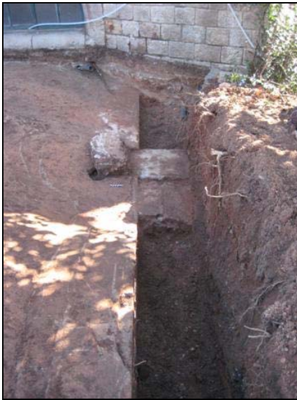
Vista SE dels contraforts i el pegat
