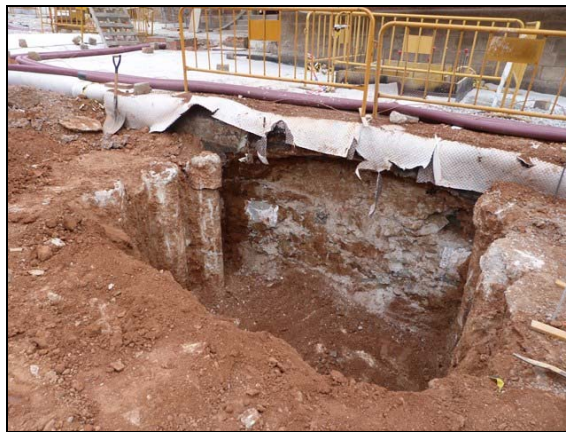
Vista del lateral de la galeria de R200 a l'interior de la Cala 800
