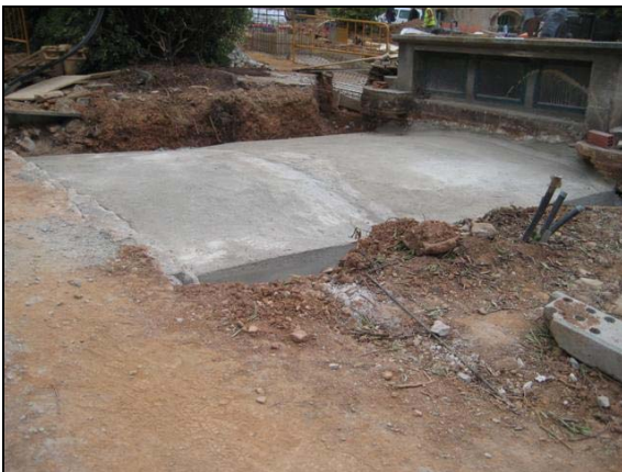
Tram 1 de R600 ja amb el reforç de formigó
