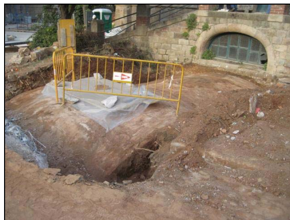
Vista de la galeria del tram I un cop destapada tota la seva superfície
