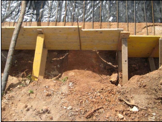
Imatge del contrafort UE 427
