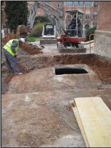
Vista SW del Tram 2 de la Rasa100 al seu inici durant els treballs. S'observa la claraboia i l'estratigrafia que la cobreix
