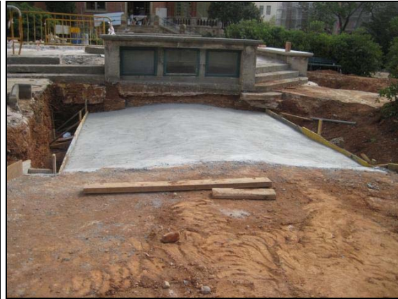
Imatge del tram 3 un cop reforçat amb formigó
