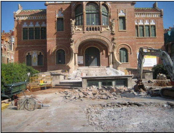
Imatge NE de R700 a l'inici dels treballs
