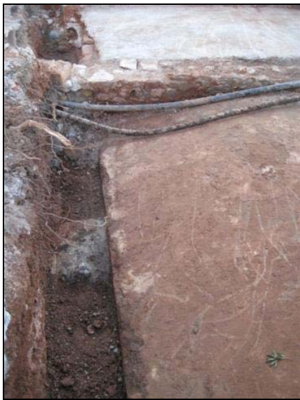
Vista SE del contrafort UE 319
