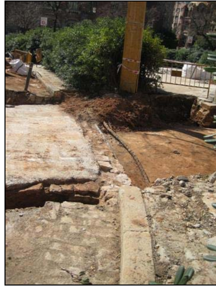
Vista del límit entre el tram 1 i el tram 2 separats per la vorera i la seva fonamentació
