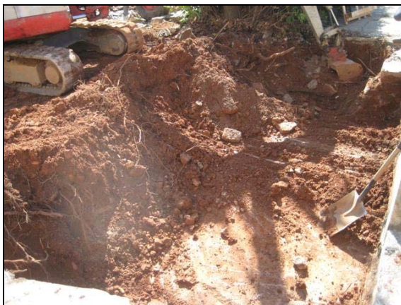
Estratigrafia sobre la volta de la galeria
