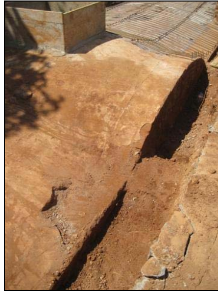
Tercer contrafort de R700a
