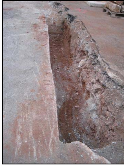
Vista SW de la R100b del 1er tram
