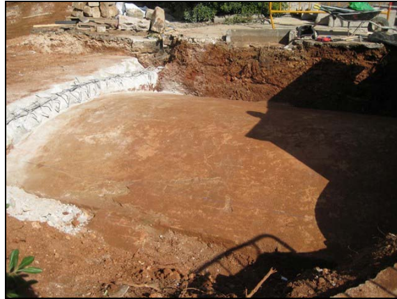
Vista del tram 3 amb la volta original. A mà esquerra s'observa part de la planxa formigó del tram 2.
