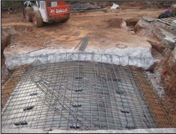
Preparant per formigonar el tram 3
