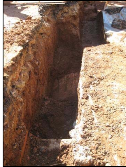
Contrafort de la galeria original UE 119
