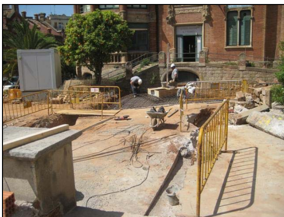
Preparant la malla de ferro per formigonar el tram 1
