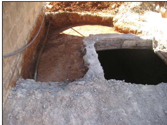
Vista SW de la zona de la claraboia amb la franja no formigonada
