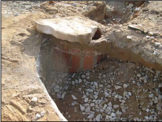
Final de la R100b del 2on tram on s'observa aquest nivell de grava i el desguàs
