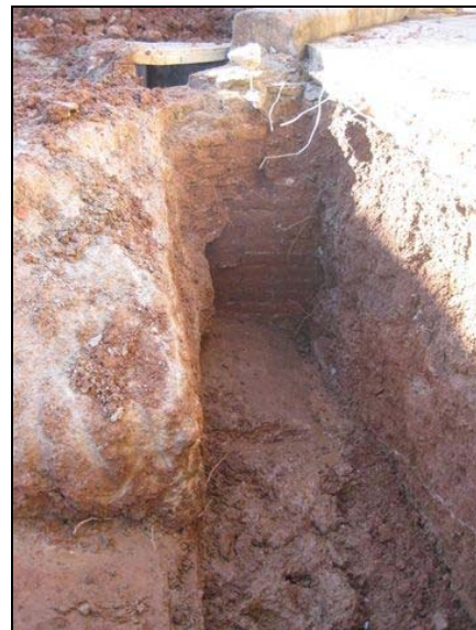
Detall del contrafort i la paret del respirador
