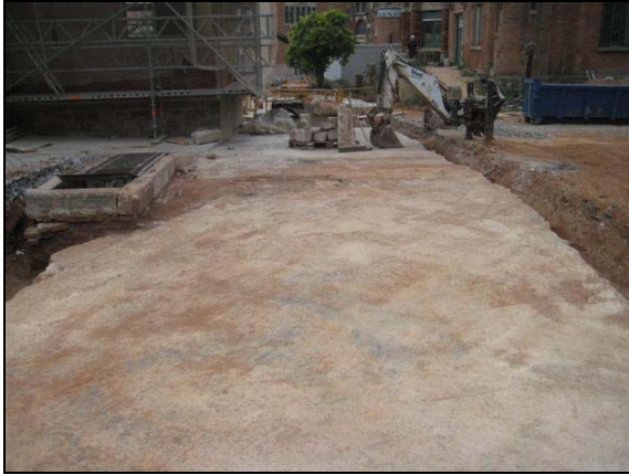
Vista SW de R200 tram 1 on veu el reforç de formigó que es recolza sobre la galeria original, un cop picat l'asfalt
