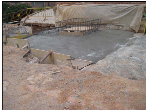
Tram 2 R100 un cop formigonat
