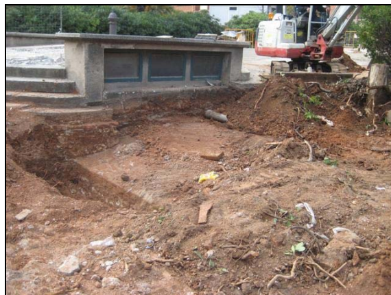
Vista nord del tram 3 un cop rebaixada estratigrafia que cobria la volta original
