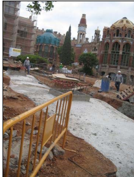
Formigonada la part de volta original del tram 1 de R700
