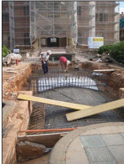
Preparant per formigonar el tram 1 de R700
