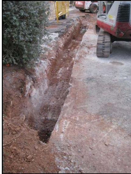
Vista SE de la R100a al 1er tram
