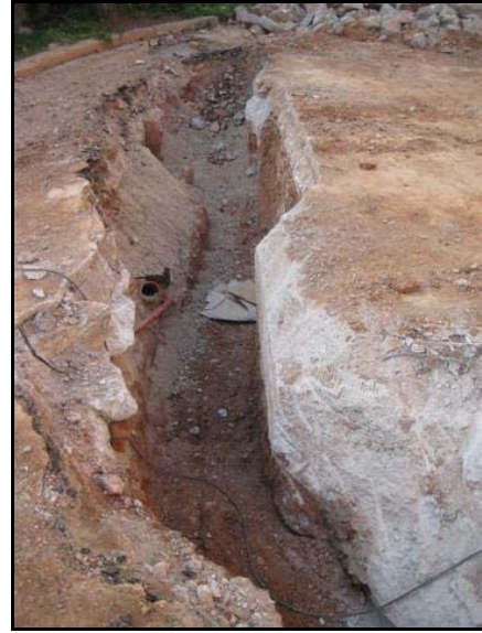
Vista SW dels diversos serveis detectats en aquest tram
