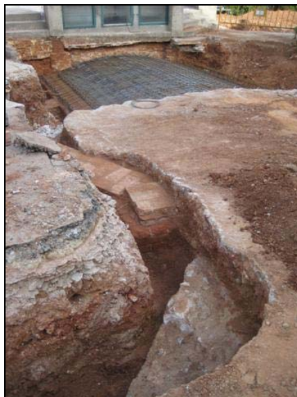
Vista NW del Tram 2 i les estructures UE 205, en primer pla i UE 509 i UE 510 en segon
