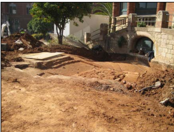
Vista oest del Tram 1 de R500 un cop acabat
