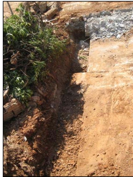
Imatge NW de R600b del tram 3 i el contrafort documentat
