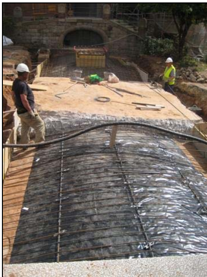
Treballs previs al formigonament dels trams 1 i 3 de R400
