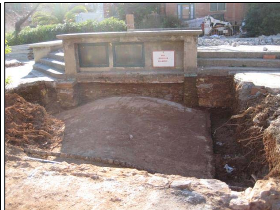
Vista R300 al tram 2 un cop acabat el rebaix
