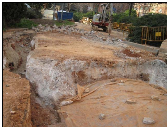
Vista SW del Tram 3 de la Rasa 100 on s'observa la planxa de formigó que ja reforça la volta original de la galeria.
