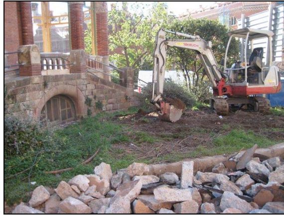
Vista R300 a l'inici dels treballs al tram 1
