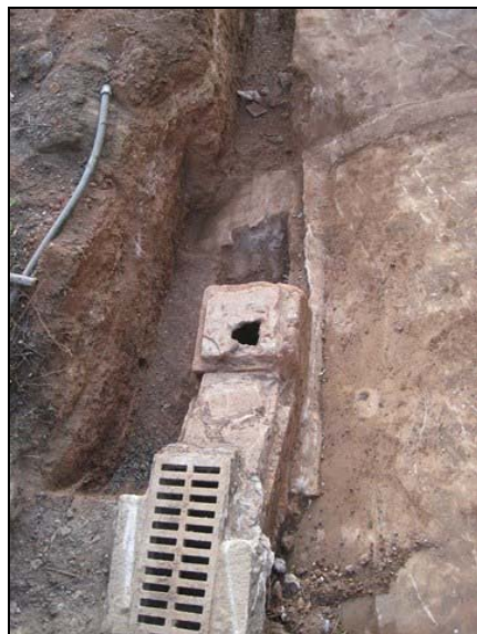
Imatge de les estructures UE 608, 609, 611 i 612
