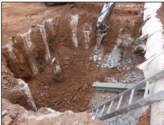
Imatge dels micropilotatges
