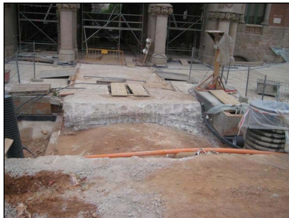
Vista SW del segon tram de R700 on s'observa a la part central una petita zona de la volta original i la reestructuració a banda i banda de la galeria.
