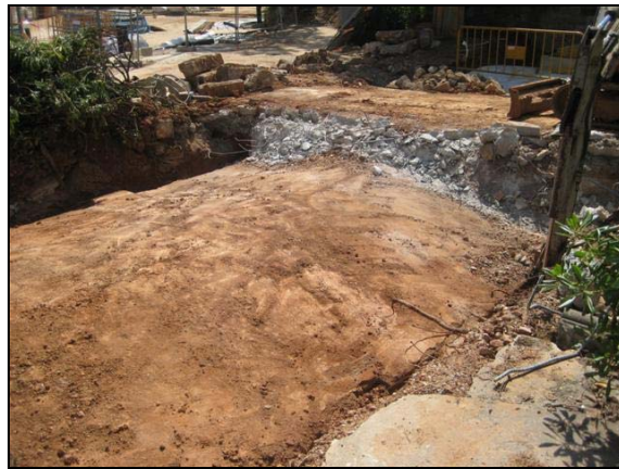
Vista oest del tram 3 amb la volta de maons a primer pla i del tram 2 amb la planxa de formigó que la reforça.
