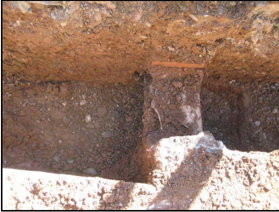
Servei elèctric UE 107
