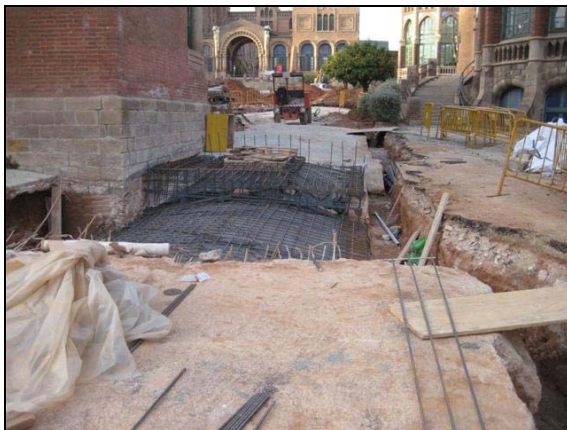
Preparació amb el mallat de ferro per abocar el formigó
