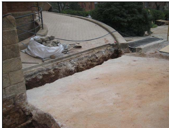
R200a del primer tram a continuació de la paret del Pavelló central.
