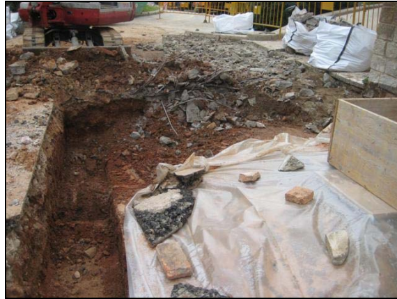
Planxa de formigó intermitja entre la preparació del paviment i el nivell que cobreix la galeria.
